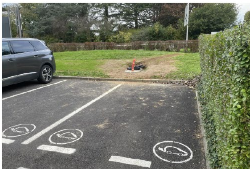
Les bornes, en cours d'installation.
